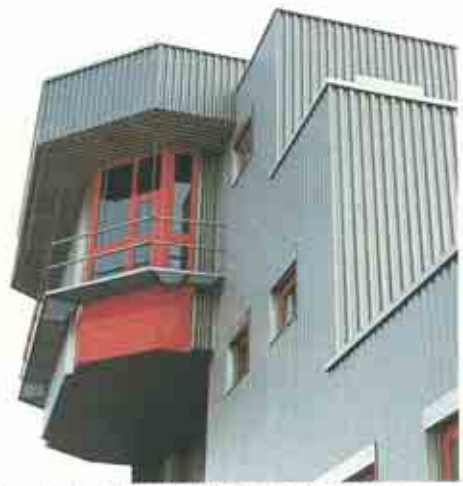
Fassade des Stellwerks Heiligenstadt-Wien
