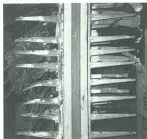
Kabelabschottung (Mineralwollschott, System Beckonit, nach Brandversuch)
