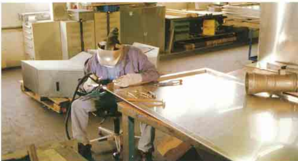
Vorbereitende Blechverarbeitung für das Isoliersystem der Kryo-Kammer
