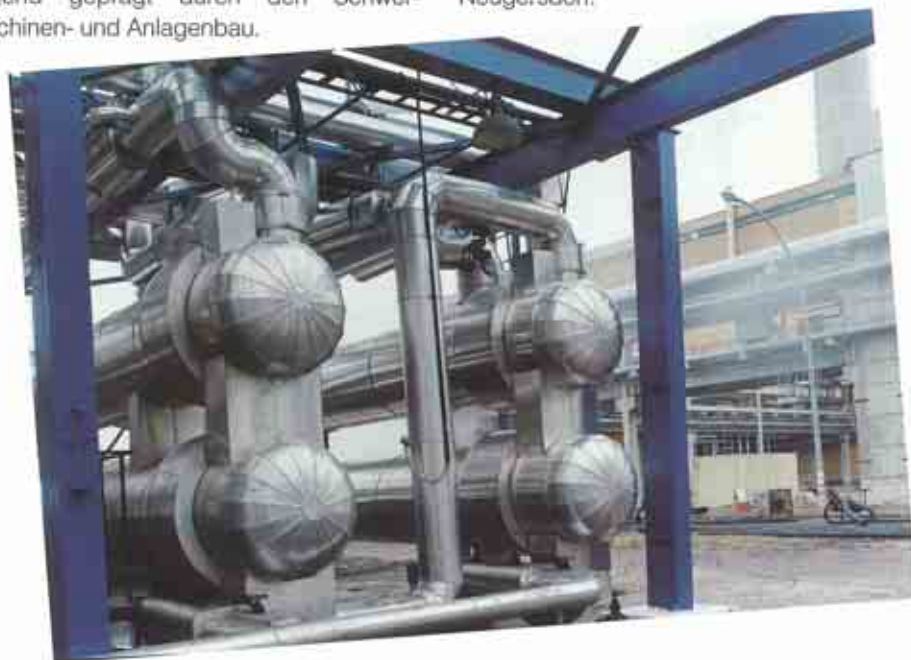
Das Photo zeigt vier von acht Wärmetauschern, die KAEFER Neubrandenburg im Kraftwerk Neubrandenburg isoliert hat.
