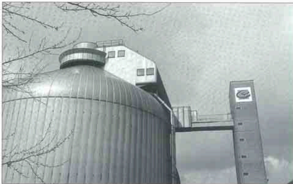
Gasreinigung in Seehausen: Im Bremer Klärwerk Seehausen isolierte KAEFER mit verzinktem Blech und Mineralwolle die Prozessgasreinigungsanlage. Durch ein neues Verfahren wird hier jetzt die im Klärprozess anfallende Stickstoffmenge erheblich reduziert.
