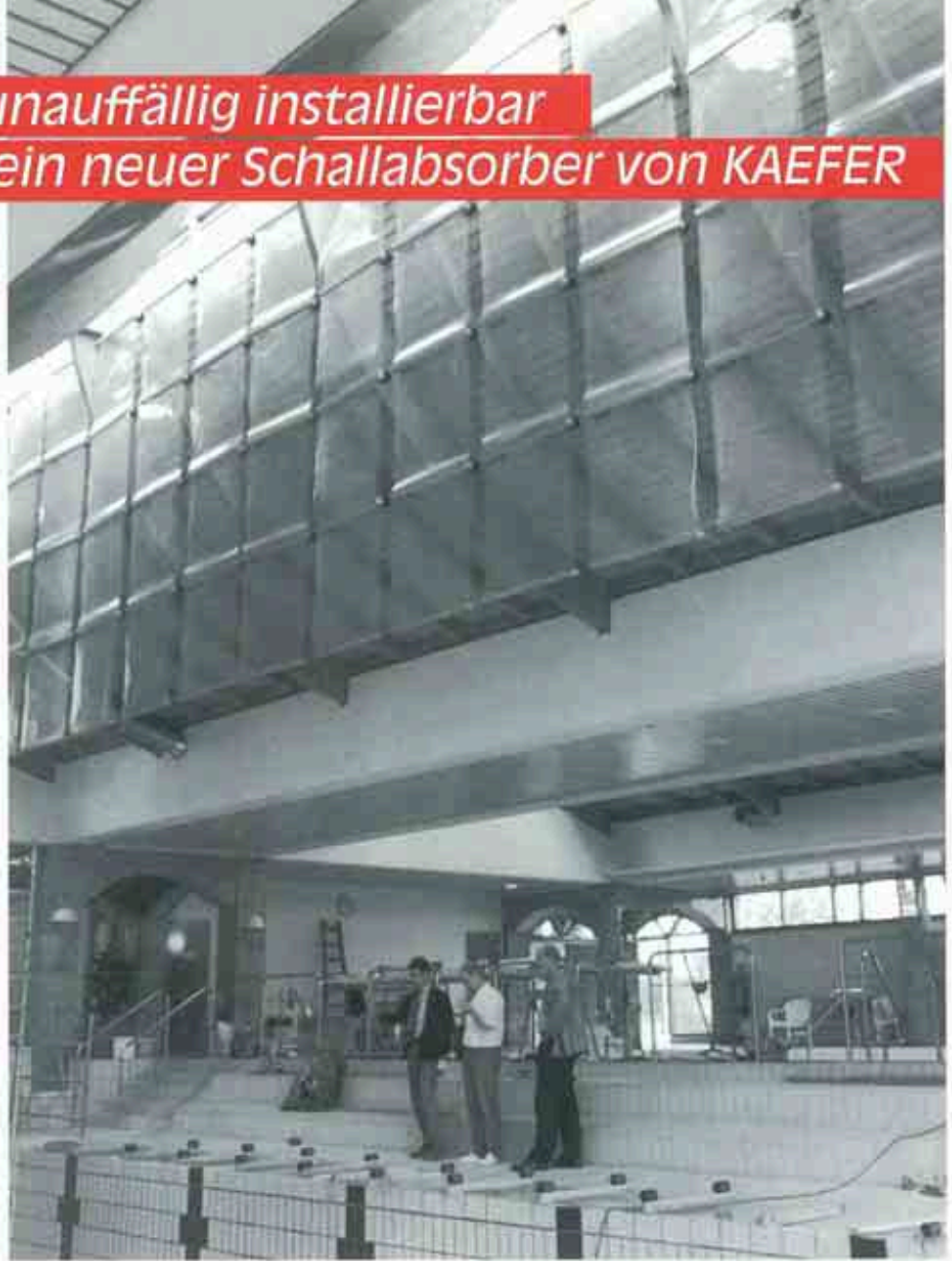
Freizeitbad "Die Welle". Microsorbermontage.
