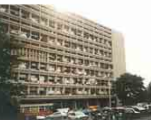
Corbusier Haus, Berlin: Sanierung der Decken
