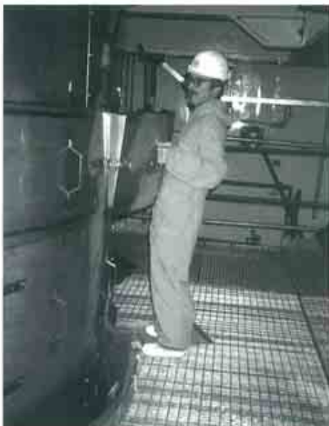
Lutz Heiter bei der Kassettenmontage im Kernkraftwerk
