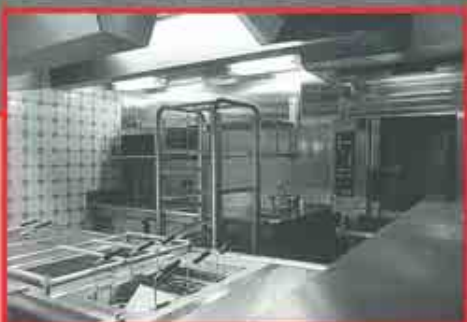
KAEFER lieferte und montierte die Wand- und Deckenverkleidungen für alle Bordküchen und Pantries auf dem neuesten Kreuzfahrtschiff „Super Star Leo“ der Jos. Meyer Werft in Papenburg
