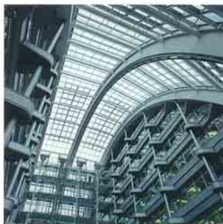
Brandschutzmaßnahmen an tragenden Bauteilen und Brandschutzfugen F 90 – Ludwig-Erhard-Haus/Neue Berliner Börse
